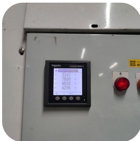
เปลี่ยนของใหม่เป็น Schneider PM2230 พร้อมตั้งค่า Modbus RTU
