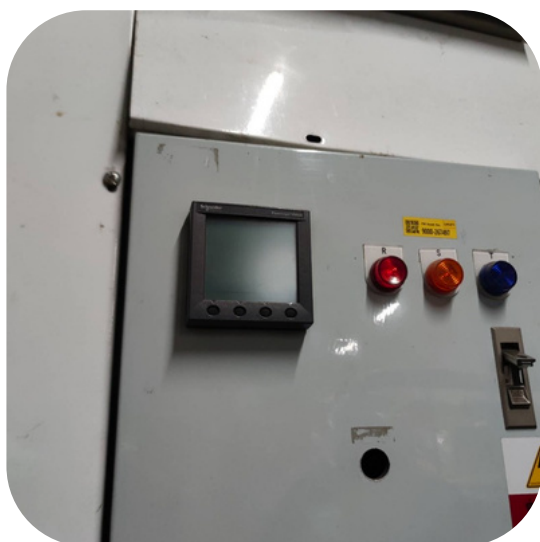
ของเดิม ปัญหาหน้าจอไม่ติด Schneider PM800
