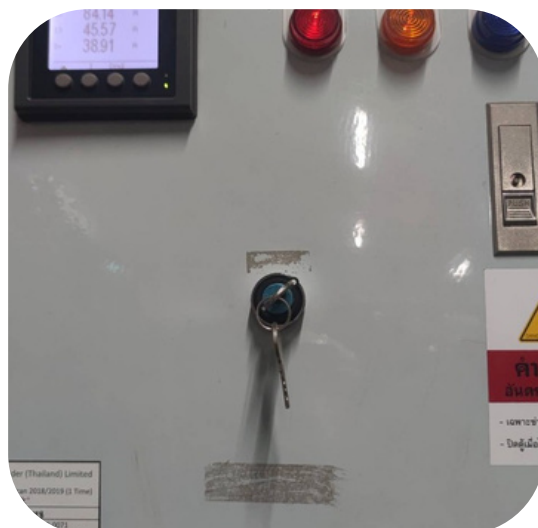
เปลี่ยนของใหม่เป็น Schneider PM2230 พร้อมตั้งค่า Modbus RTU
